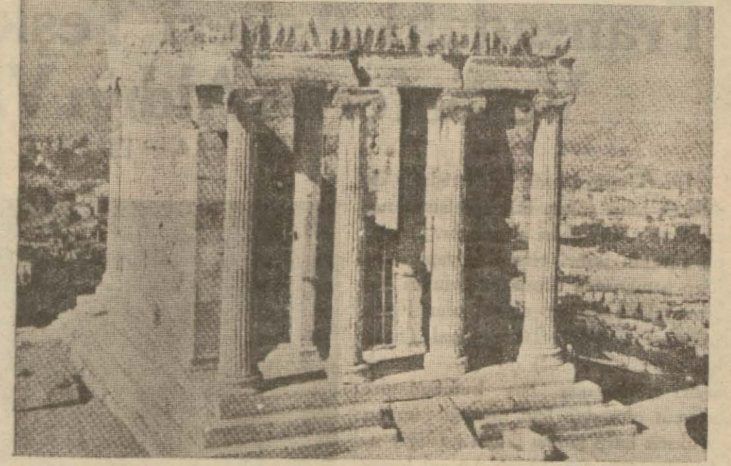
Mabedin yıkılmadan evvelki hali
